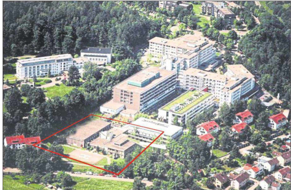
PLATZ SCHAFFEN will die SRH Holding am Klinikstandort Langensteinbach. Das Haus Kraichgau mit Reha-Einrichtungen wie Sport- und Schwimmhalle (rot markiert) soll 2017 abgerissen werden. Der Neubau einer Psychiatrie mit 92 Betten ist geplant. Foto: SRH
